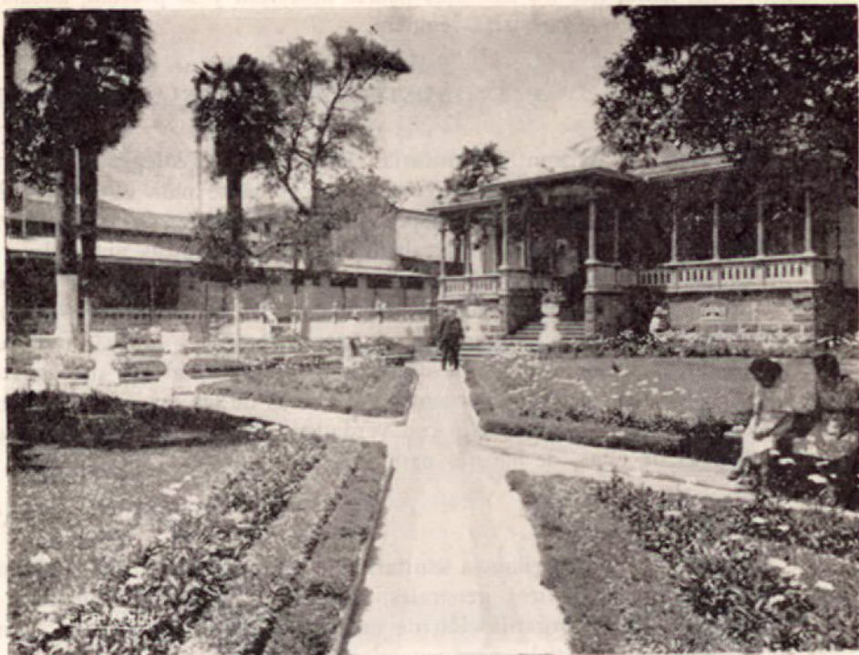
Otro precioso jardín del Asilo Chapuí, que conduce a los salones cuya fotografía sigue.
